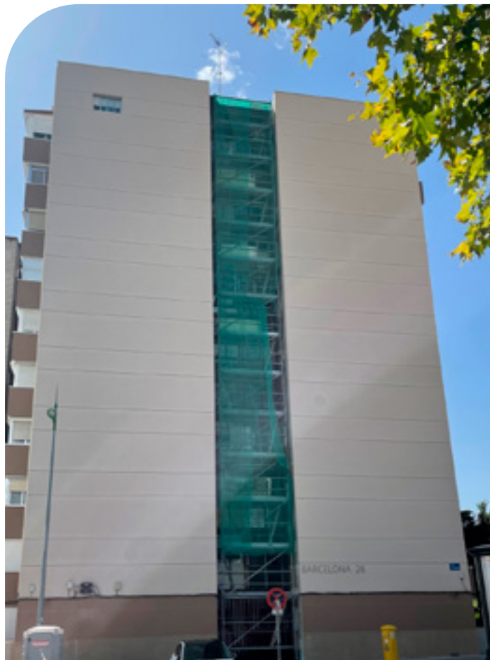
OBRA DESARROLLADA POR NUESTRO DISTRIBUIDOR SEGOPI EN FUENLABRADA
